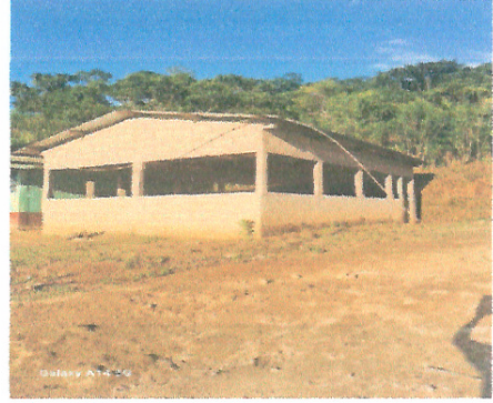
Foto 2: Mejoramiento balcones de la cocina
