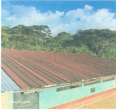
Foto 1: Mejoramiento cubierto de lamina
